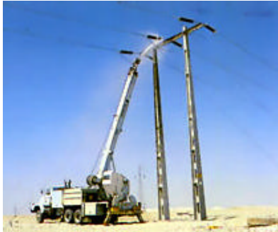
Figura 1: lavado de aislador en línea de transmisión.
